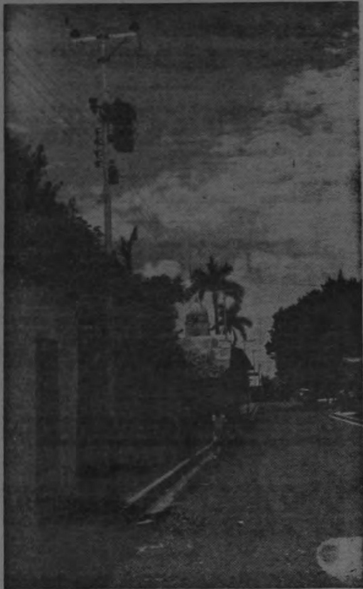
Vista de la nueva postería del tendido de redes instalada por el ICE al hacerse cargo del suministro de energía eléctrica en la ciudad de Bagaces.
